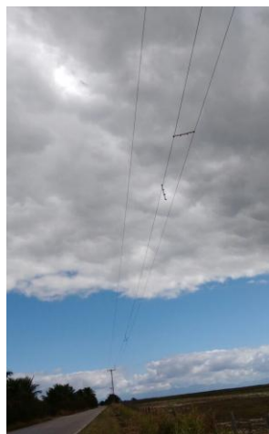
QUI01 - Espaçadores soltaram, rede ficou desnivelada
